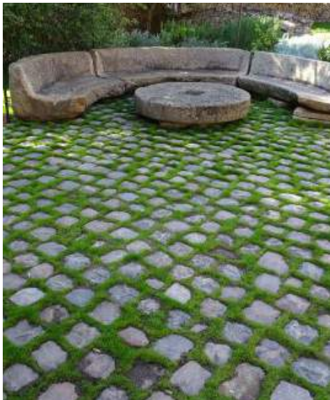
Pavés granit gris de réemploi avec joints gazonnés
