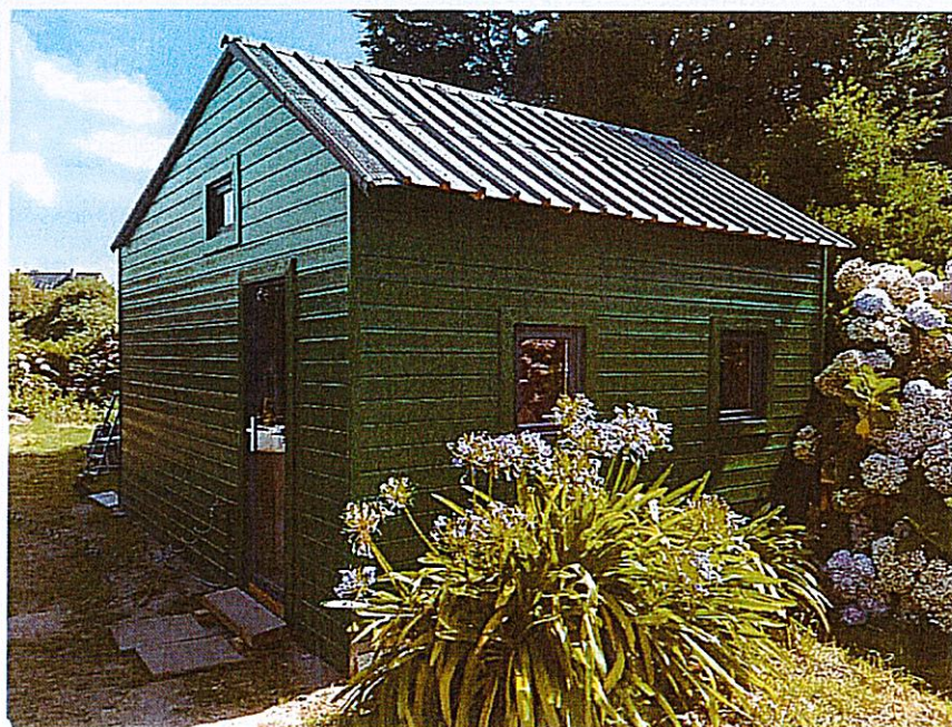
FAÇADE NORD ET OUEST
